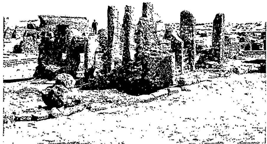
Détails de construction. — تفاصيل من الأبنية
